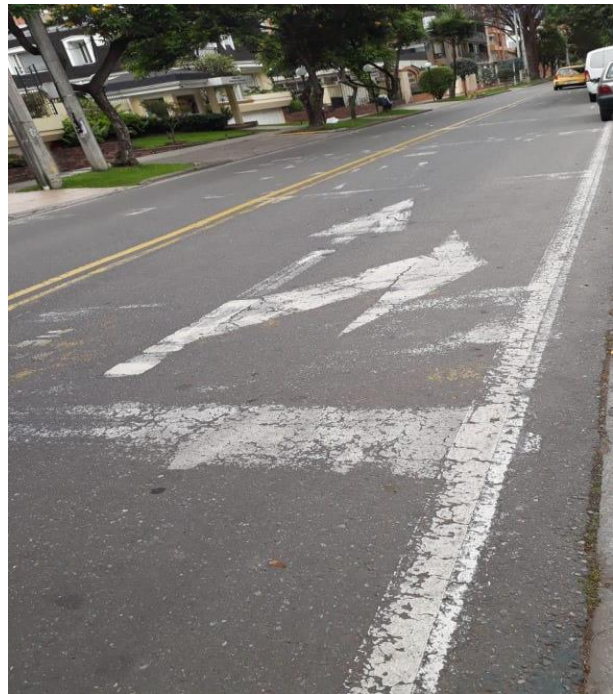
Imagen N. 23 y 24 Deterioro en señal de tránsito horizontal
