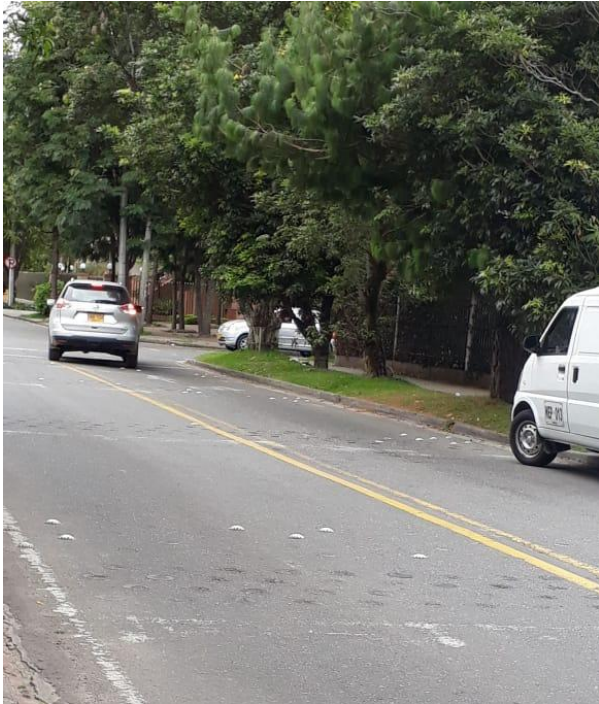
Imagen N. 23 y 24 Deterioro en señal de tránsito horizontal
